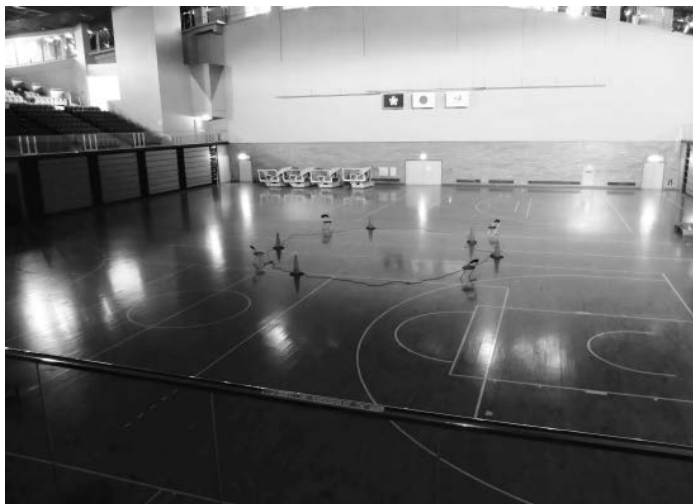
国際大会も開催されるアリーナは、震災で天井の一部が壊れ現在改修が進んでいる。東京オリンピック2020のキャンプ地にも使用される予定がある。
