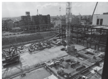
図9 建設中の総合体育館(2020年竣工予定)
