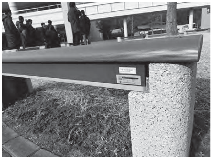
震災後に設置されたベンチ。ベンチ部分が開口レコンロになっており、炊き出しが出来るように工夫されている。
